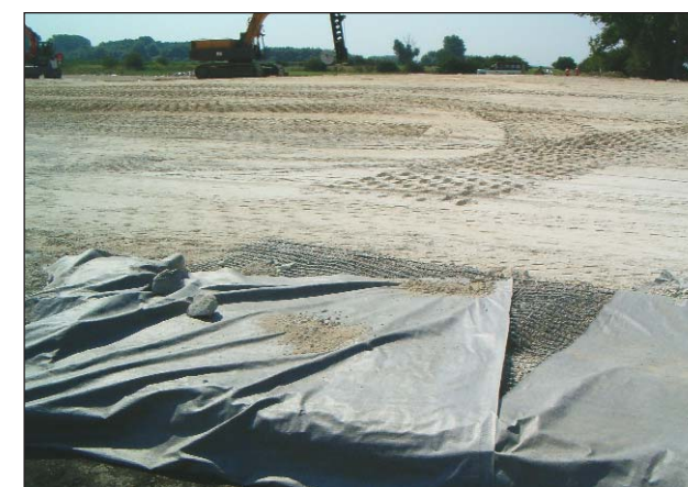
5. ábra - Visszahajtott SYTEC Tenax LBO 333 georács + textília
