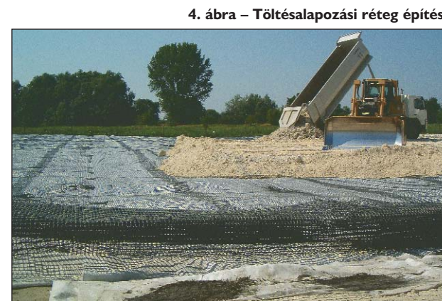
4. ábra - Töltésalapozási réteg építése
