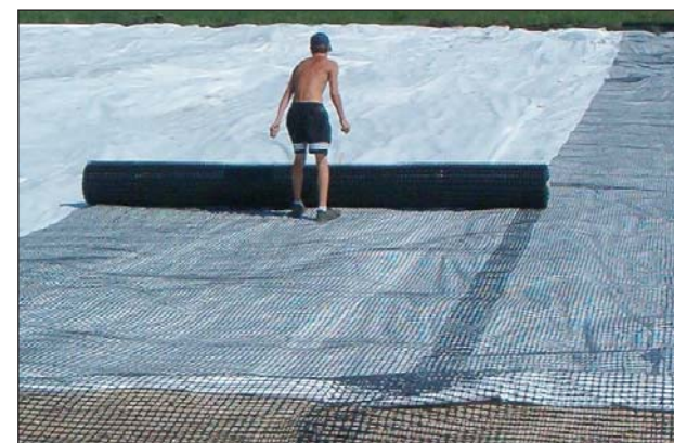
3. ábra - SYTEC Tenax LBO 333 georács terítése
